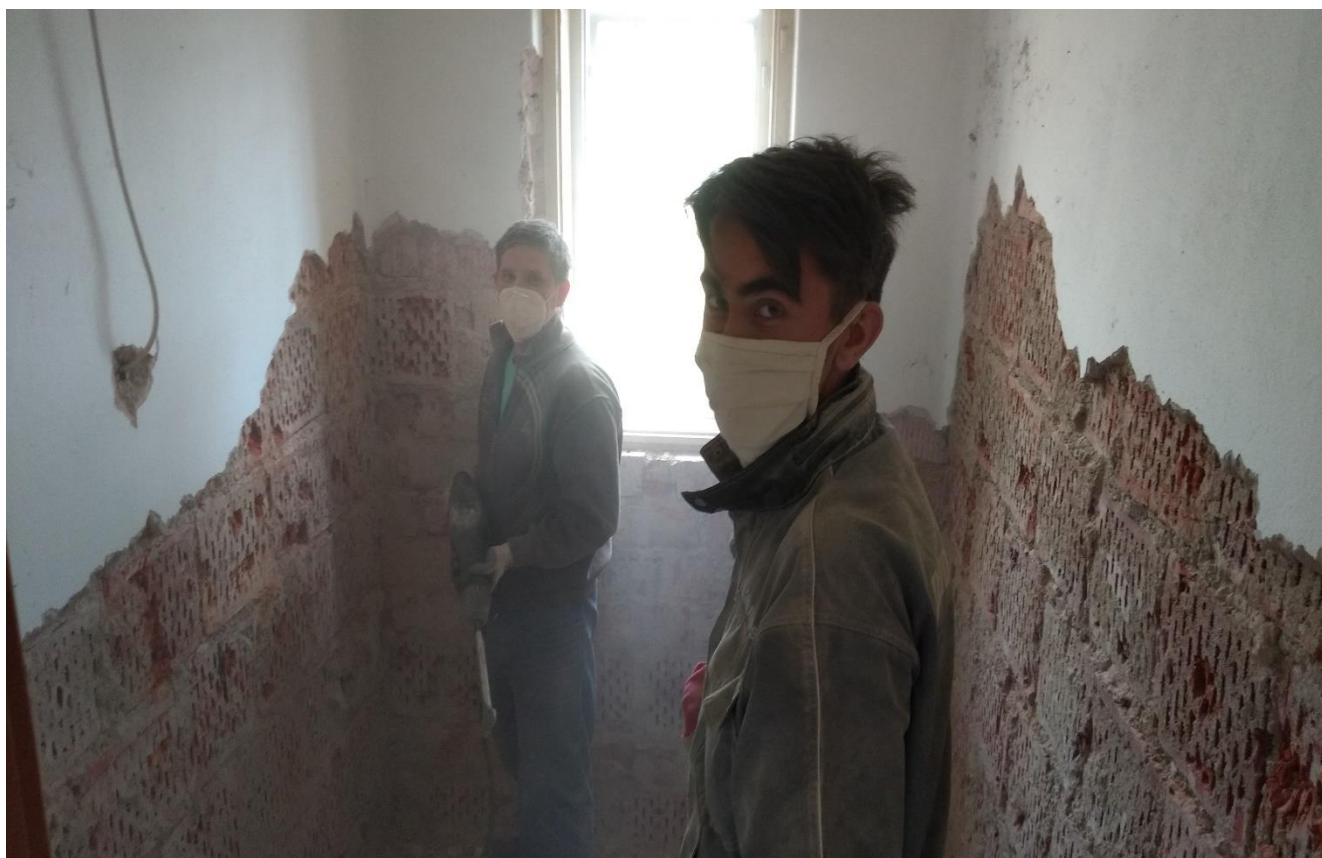
Rekonstrukce budovy obecního úřadu, 16. 5. 2020, Záchlumí, foto archiv J. Peřina
