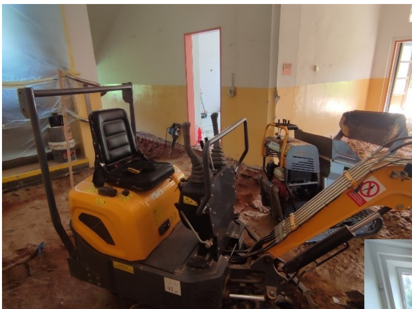
Fotografie ze zahájení rekonstrukce podlah v budově školy:
